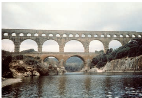
Das römische Aquädukt von Nîmes in Frankreich. © HR/SWR
